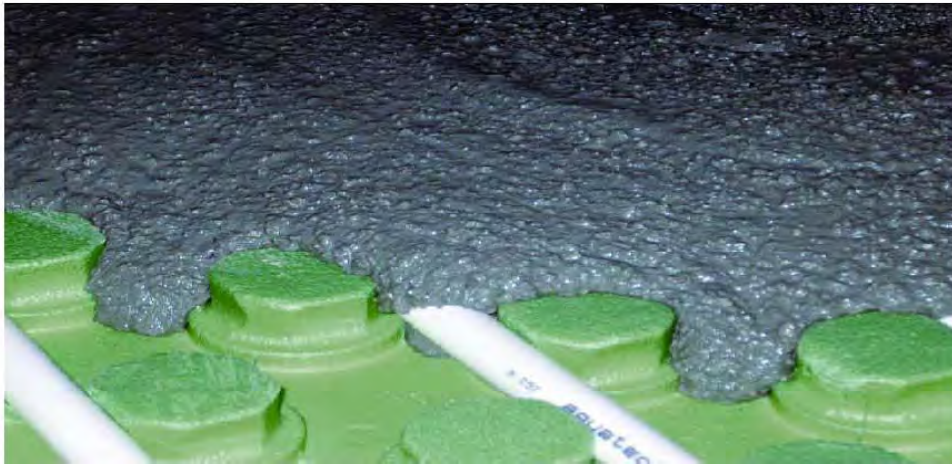
Figura 3 – Particolari di posa su pannello radiante
