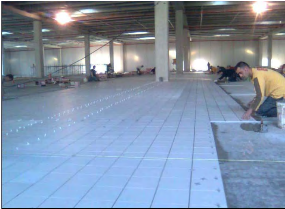
Figura 4 – Posa di ceramica su Fonomix. Il getto è stato eseguito senza giunti.
